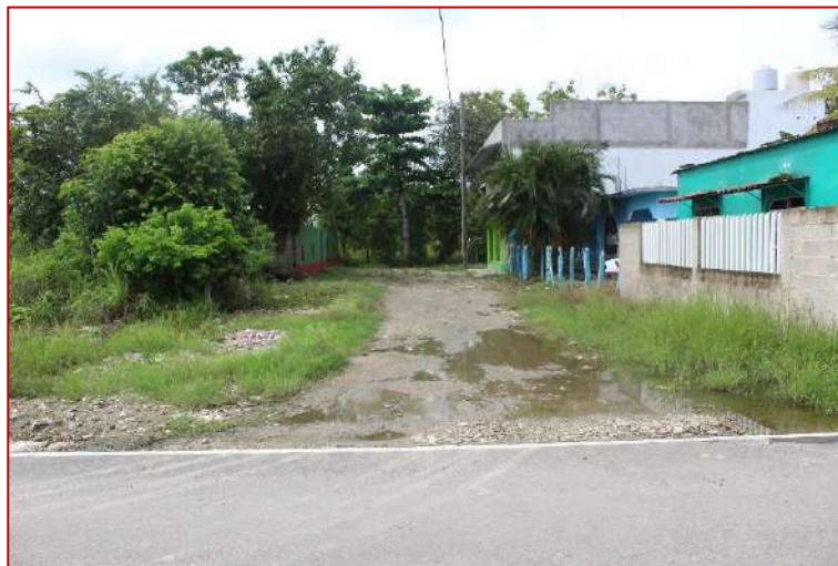
Fig. 109. Vivienda en situación de vulnerabilidad o riesgo
